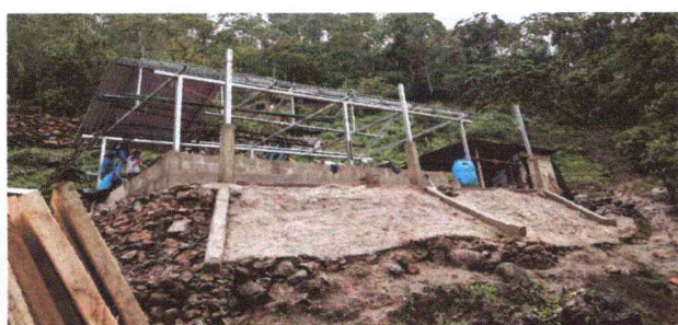
Foto 3: Avance en la construcción del muro de contención.
