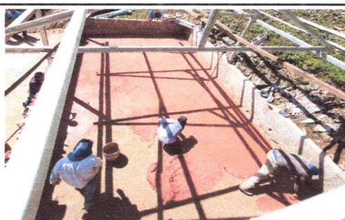
Foto 6: Mejoramiento de piso.
