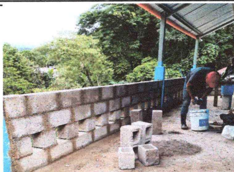
Foto 2: Construcción de baranda de seguridad en la parte frontal del aula.
