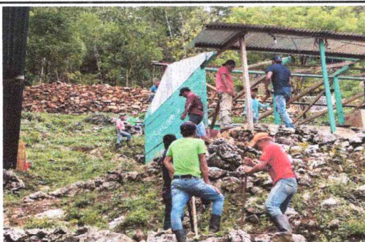
Foto 1: Se inician los trabajos retirando la la mayor parte de la estructura dañada de la escuela.
