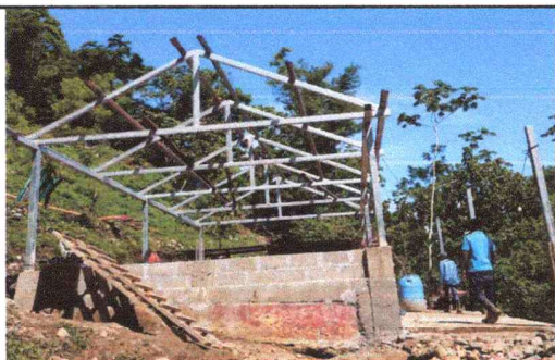
Foto 5: Colocación de estructura y bases para las paredes y techo de la escuela.
