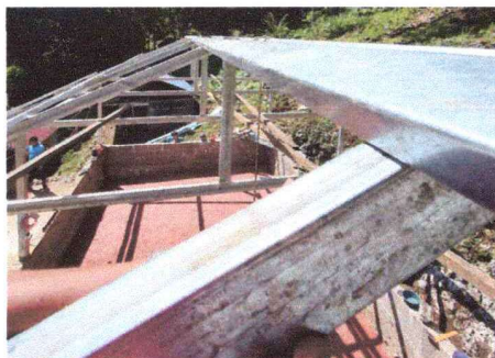
Foto 4: Estructuración y soldadura del techo.
